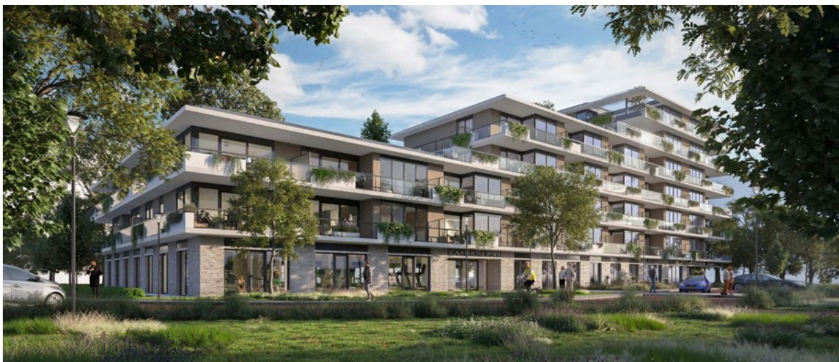
Complete W-installaties van 53 duurzame appartementen in Bergen op Zoom
