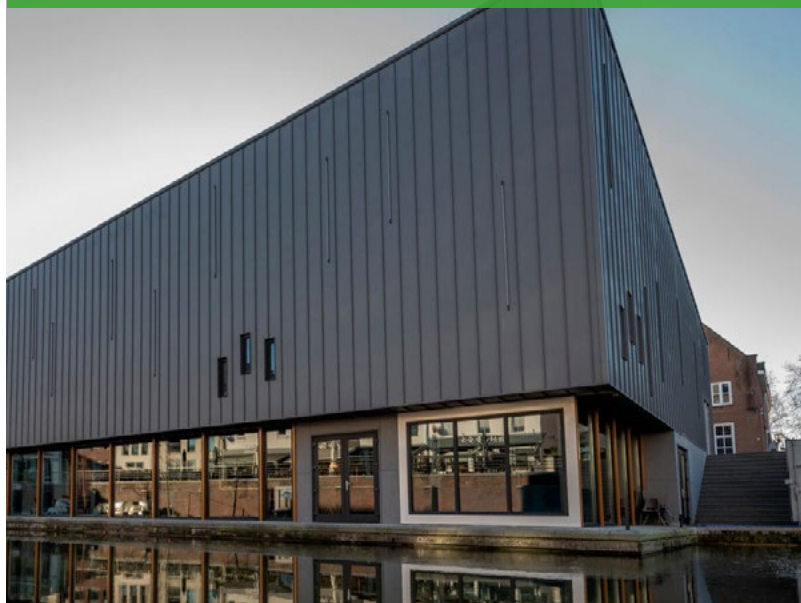
Nieuwbouw bioscoop De Koning van Engeland in Hulst
